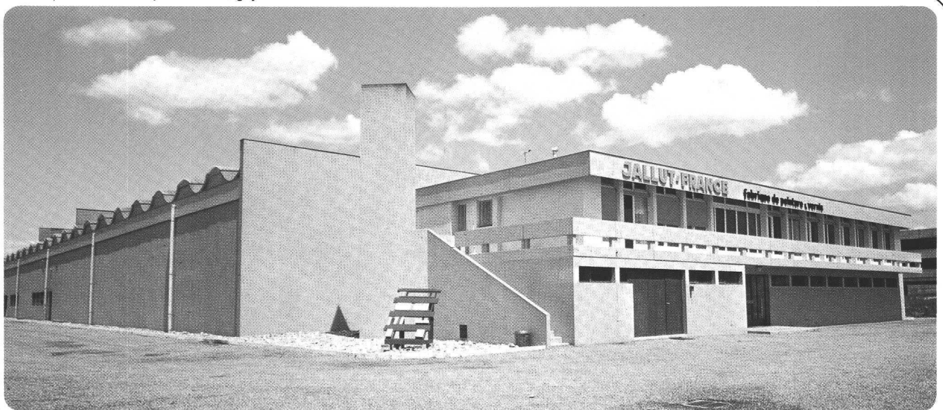
Usine JALLUT-FRANCE S.A., Annemasse
