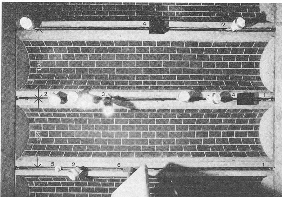
Fig. 11. — Equipement du plafond dans les salles d'exposition.
