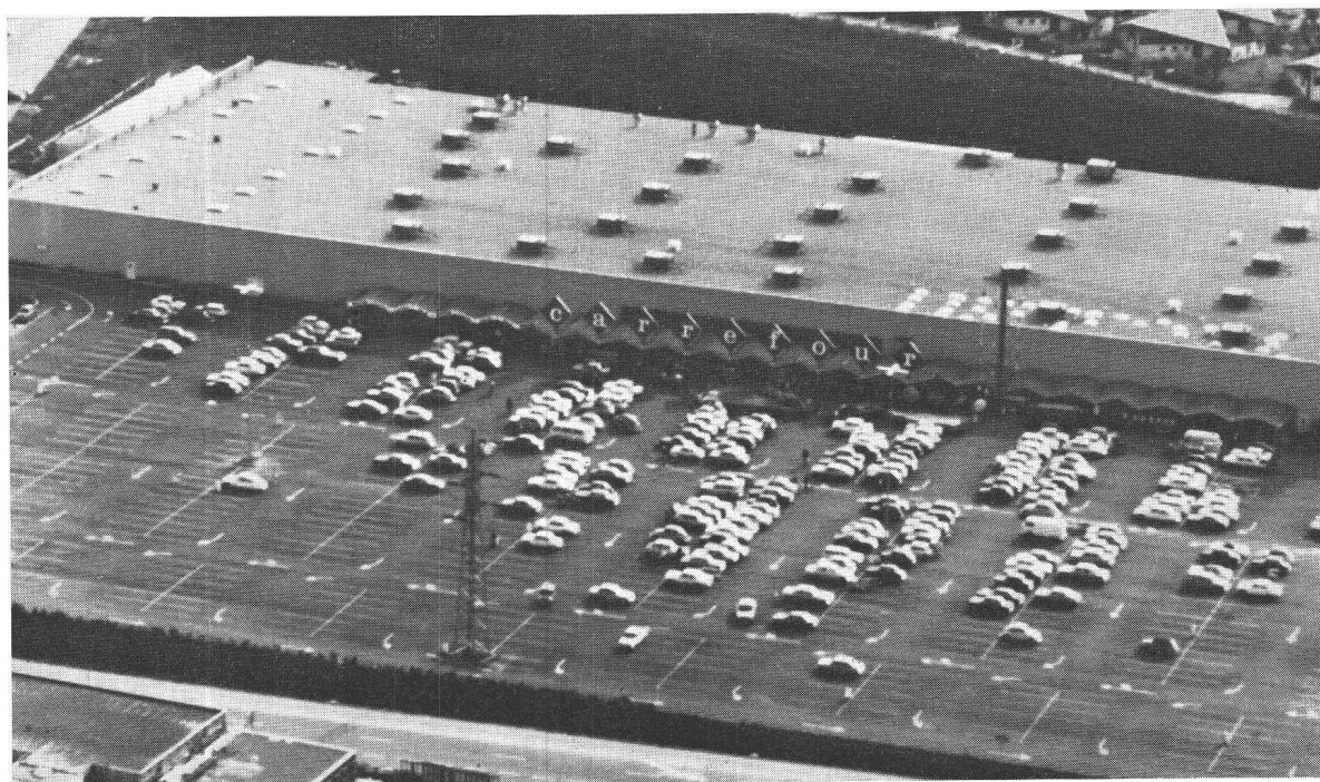
Carrefour Hypermarché Romanel S.A. Conception : Carrefour France Ingénieurs et architectes : Bureau Beric S.A. Genève
