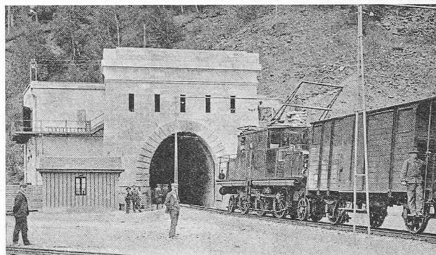
Fig. 4. — Traction électrique triphasée au tunnel du Simplon, 1906.
