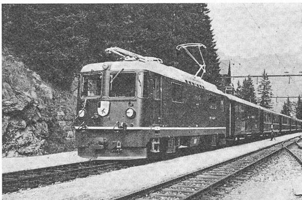
Fig. 31. — Locomotive à thyristors Bo'Bo' de la série Ge 4/4<sup>II</sup> du Chemin de fer rhétique (voie métrique). Poids 50 t, puissance unihoraire 2300 ch, vitesse max. 90 km/h.
