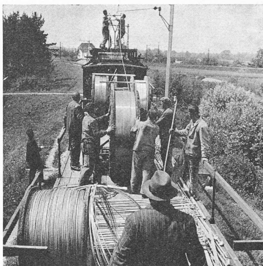
Fig. 52. — Remplacement d'une ligne de contact.
