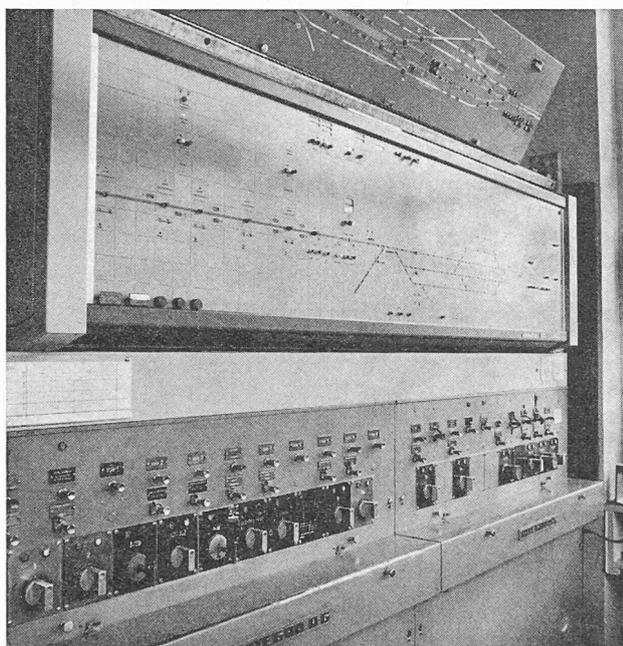
remplacer cet appareil et transformer le système d'autorisation à leviers mécaniques par un appareillage électrique ne comprenant que des touches et des voyants lumineux.
