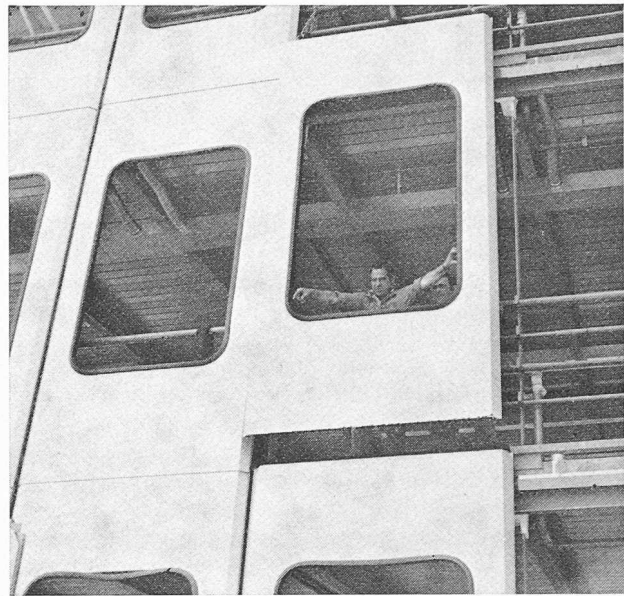
Fig. 10. — Montage d'un panneau de façade.
