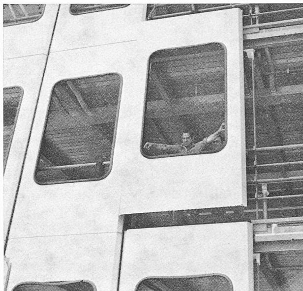
Fig. 10. — Montage d'un panneau de façade.
