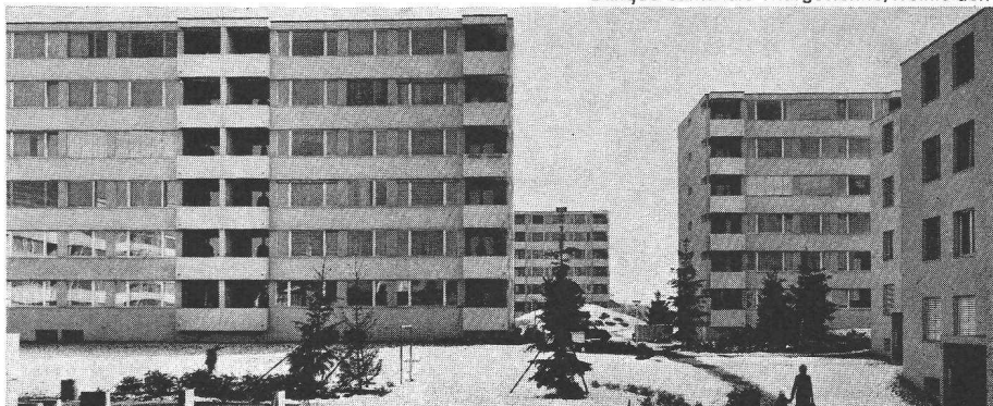
Complexe d'habitation de Rain, Jona SG
