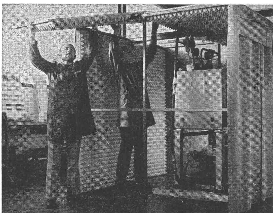
Montage d'une cabine antibruit
