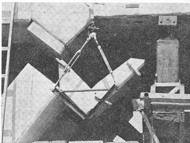
Fig. 5. — Mise en place de la pièce de liaison d'une béquille intérieure.
