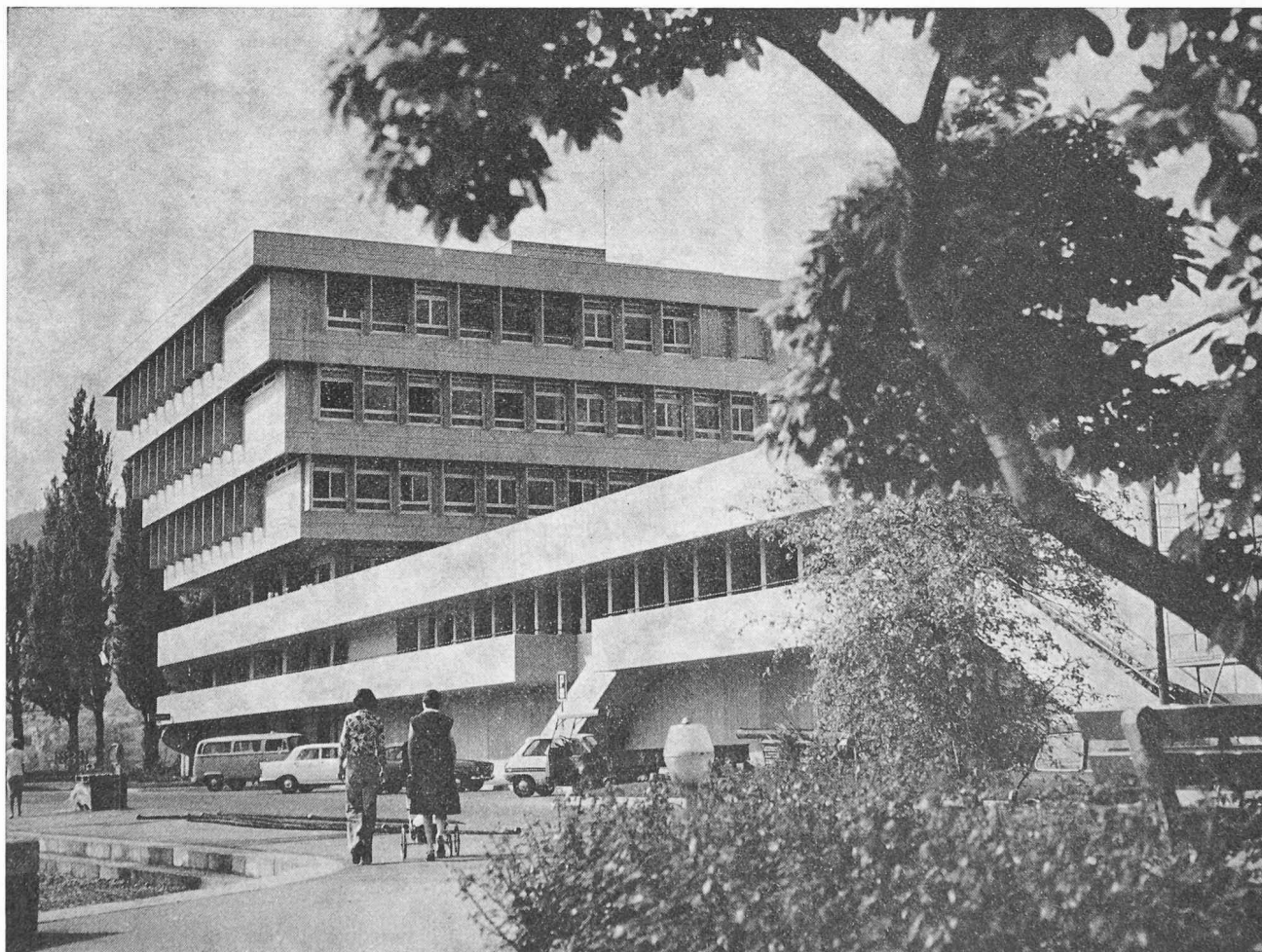
Fig. 6. — Le bâtiment administratif du complexe SIEG.
