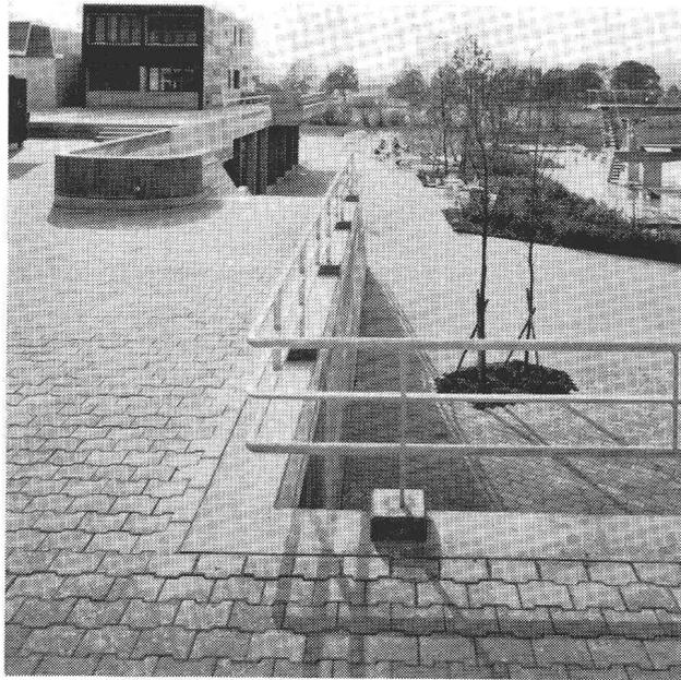
Il existe des pièces spéciales pour les extrémités des surfaces à recouvrir, ainsi que des éléments de rive, plus grands, spécialement conçus pour renforcer les bords.
