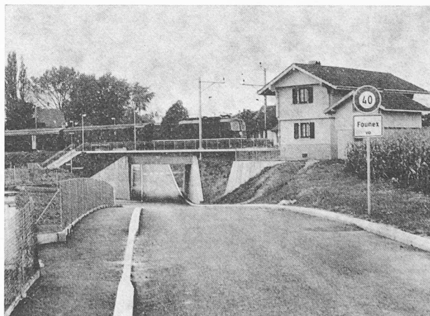
Fig. 94. — Le nouveau passage inférieur routier de la halte de Founex, mis en service le 26 septembre 1975, a permis de supprimer trois passages à niveau.
