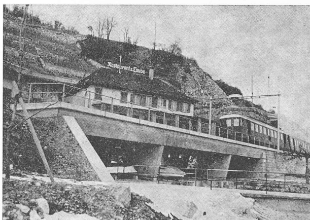
Fig. 106. — Le nouveau pont sur le port d'Alfermée, fondé sur des pieux. A l'arrière-plan, le restaurant « Zur Laube » qui a été démolé lors de la construction du viaduc de la RN 5.
