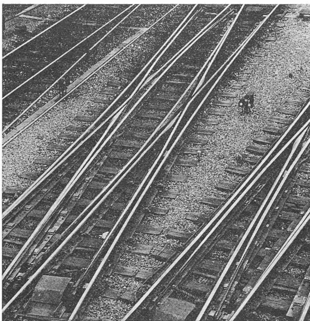
Fig. 117. — Appareils de voie.
