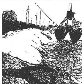
Polyfelt TS spart Zeit, Kosten und Schüttmaterial und hilft besser, billiger und schneller zu bauen. Polyfelt TS – Trenn- und Filterschicht zwischen schlammigem Boden und Kiesdrainage oder Schüttung, im Straßenbau, im Bahnbau, im Wasserbau, bei der Anlage von Sportplätzen, Lagerplätzen oder Grünflächen auf Dachterrassen.
