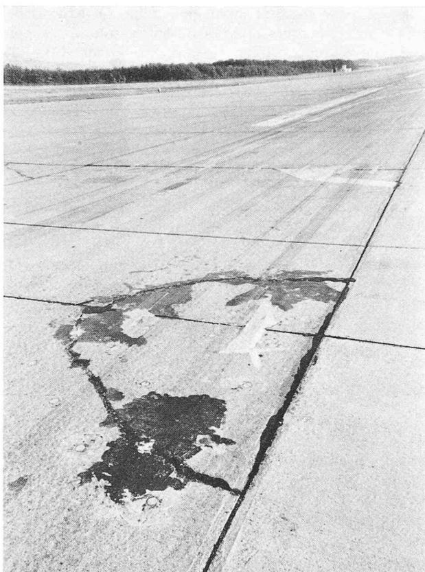
Fig. 1. — Des dizaines de dalles sont dans ce triste état. On distingue le clouage des éléments disloqués.
