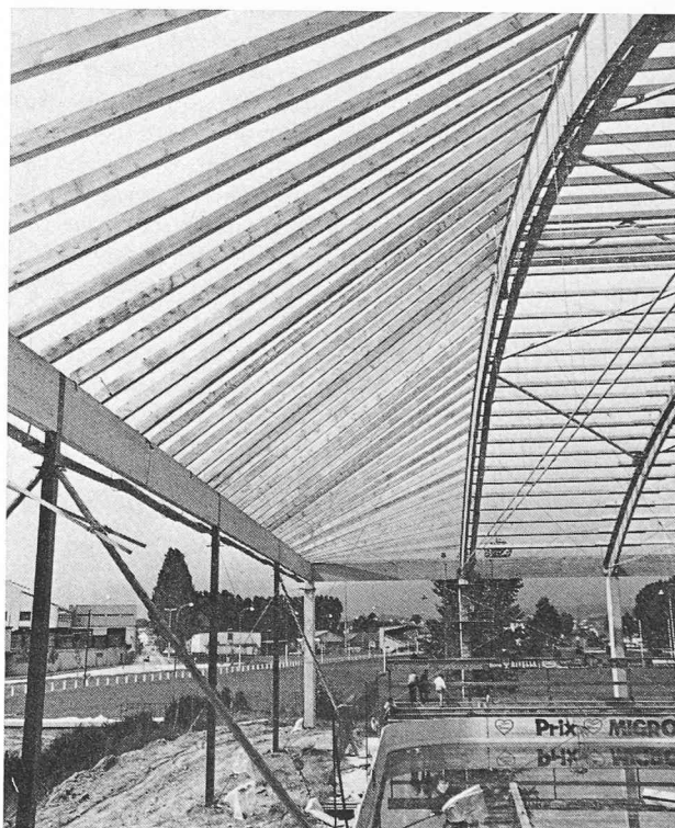
Fig. 6. — Poutre de pignon et charpente d'extrémité.
