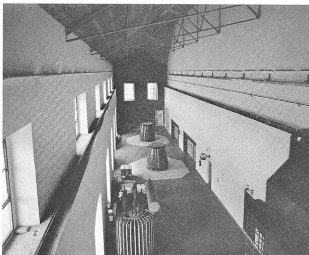
Fig. 12. — Salle des machines. Transformations terminées.
