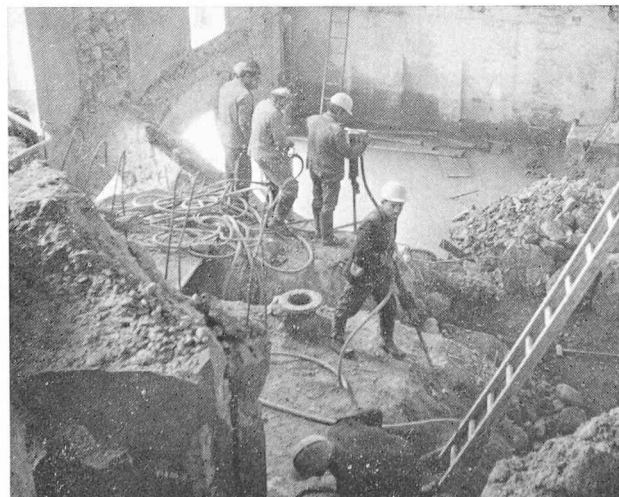
Fig. 7. — Démolition dans l'usine.
