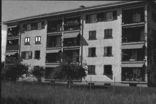
Volets d'immeubles locatifs à Bussigny
