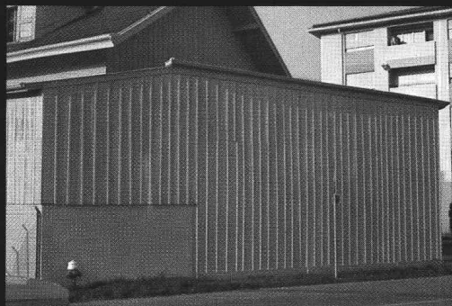
Réfection d'un hangar en bois à Bussigny
