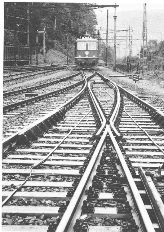
Fig. 10. — Pour le rail également, la CGST met l'accent sur l'amélioration de la sécurité dans l'exploitation : système de contrôle linéaire des trains (le conducteur visible entre les rails transmet à la locomotive des indications affichées sur le tableau de bord du mécanicien). (Photo BBC.)
