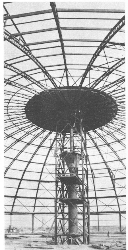
Fig. 7. — Montage à l'aide d'une tour.
