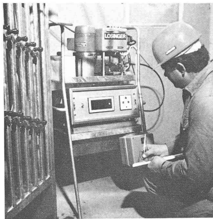
Fig. 11. — Appareillage de lecture à distance.
