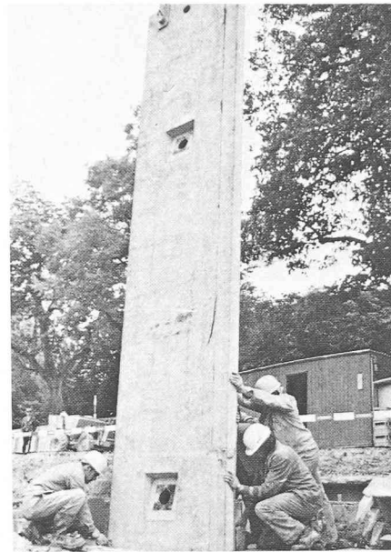
Fig. 13. — Détail d'un panneau préfabriqué en cours de pose.
