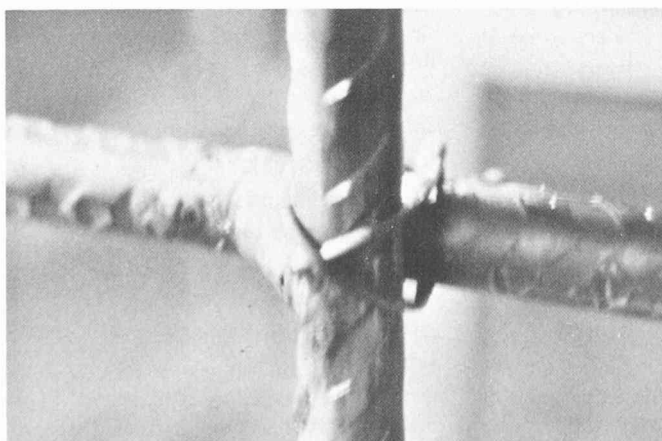
Fig. 12. — Liaison d'armatures par soudure.
