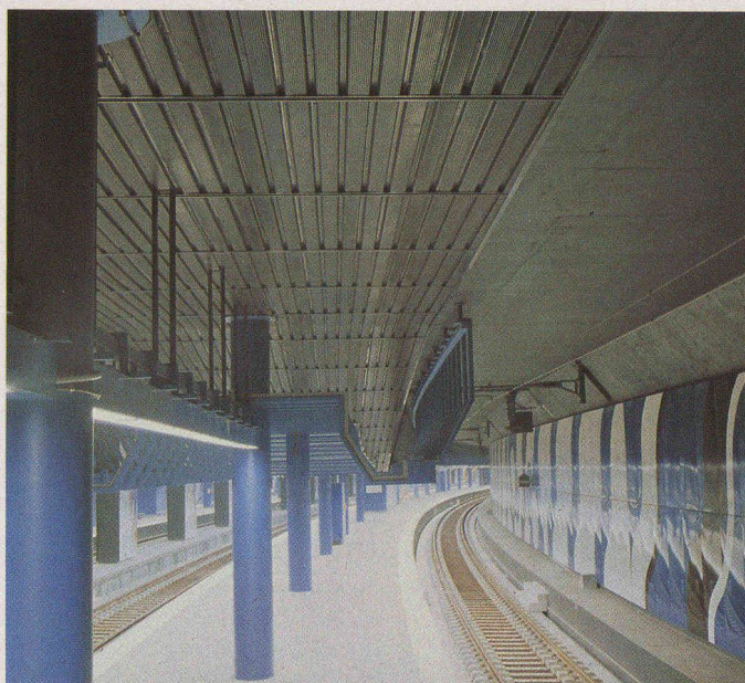
Fig. 3. — L'étage des quais avec piliers en acier.
