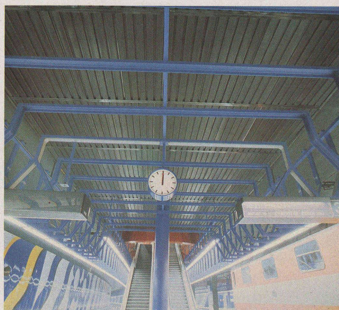
Fig. 4. — Construction nervures au-dessus de l'étage des quais.
