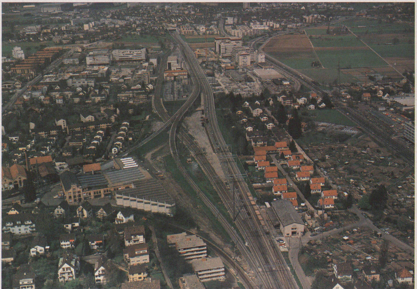
Fig. 1. — Les ponts d'Oberhauserried.
