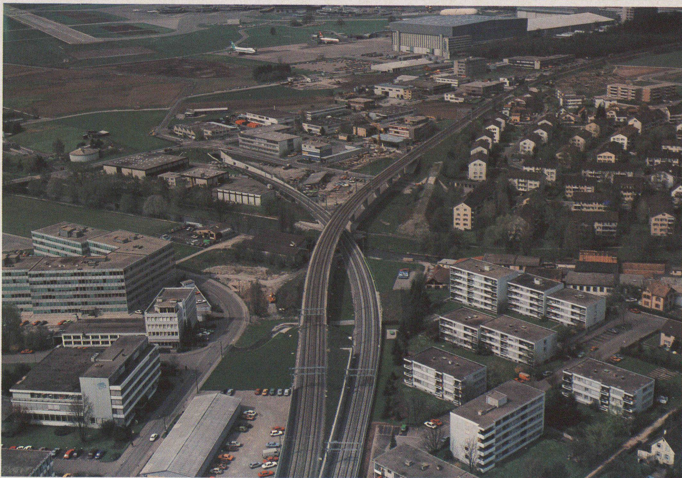
Fig. 5. — Vue générale des ponts sur la Glatt. A gauche: la ligne de l'aéroport se jette dans le tunnel de l'aéroport. Au-dessus: la ligne régionale de Kloten.
