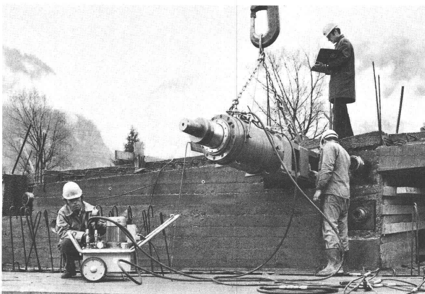
Les travaux de mise en tension et d'injection sont surveillés, contrôlés et protocolés par le chef de chantier de STAHLTON.
