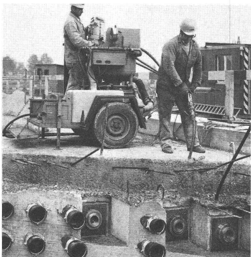
Des monteurs bien formés et expérimentés injectent les câbles BBRV avec soin et dans les délais.
