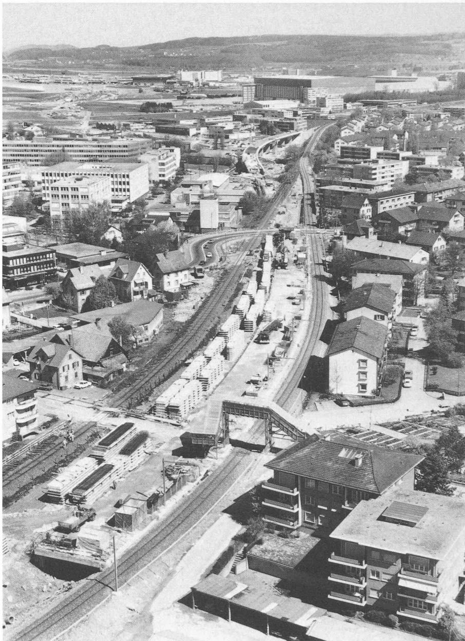
Fig. 1. — Opfikon. Vue générale des travaux en juin 1977, après le ripage provisoire de la ligne de Kloten (à gauche, l'ancien tracé).
