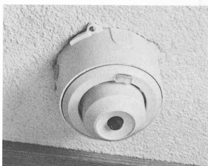
Fig. 9. — Montage du même détecteur à ras du sol, pour la détection de gaz lourds (propane, etc.).
