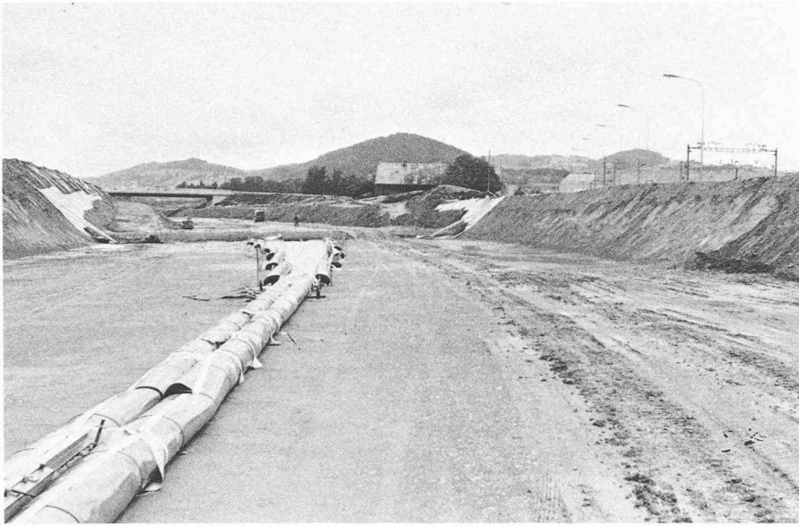
Fig. 7. — Des feuilles d'étanchéité synthétiques déjà posées sur la fondation aplanie. (Photo prise par l'auteur)
