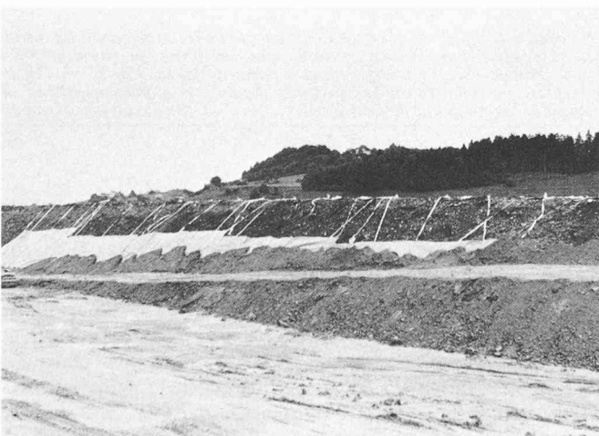
Fig. 9. — Vue sur le chantier du Breitfeld. On reconnaît une partie des feuilles d'étanchéité en Sarnafil FP qui sont remontées le long des talus et fixées grâce aux rubans enroulés pour faciliter la pose. En partie, les remblais sont déjà exécutés dans la zone horizontale ainsi que le long des talus. (Photo prise par l'auteur)
