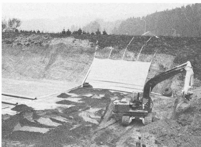
Fig. 4. — Après la pose des feuilles d'étanchéité synthétiques, tout en les remontant le long des talus, y compris la fixation suivante, une couche de sable de 20 cm d'épaisseur est mise en place avec des machines comme couche protectrice mécanique pour les feuilles de l'étanchéité. Les tas de sable éparés avant la pose de la couche de sable servent à charger les feuilles d'étanchéité synthétiques.
