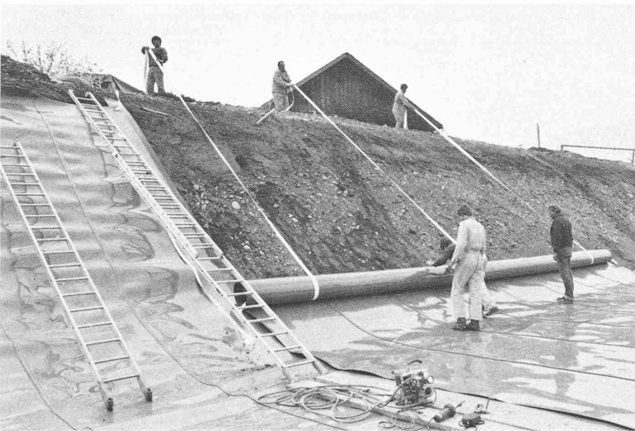
Fig. 8. — Pose et montage des feuilles d'étanchéité synthétiques en Sarnafil FP de 2 mm d'épaisseur. D'une largeur de 11,20 et d'une longueur allant jusqu'à 41,40 m, elles sont posées grâce aux rubans enroulés par l'usine. Après la pose, ces rubans ont servi en même temps à la fixation des feuilles d'étanchéité sur les talus. Les feuilles ont été posées en se superposant. (Photo: Sarna Kunststoff AG, Sarnen)
