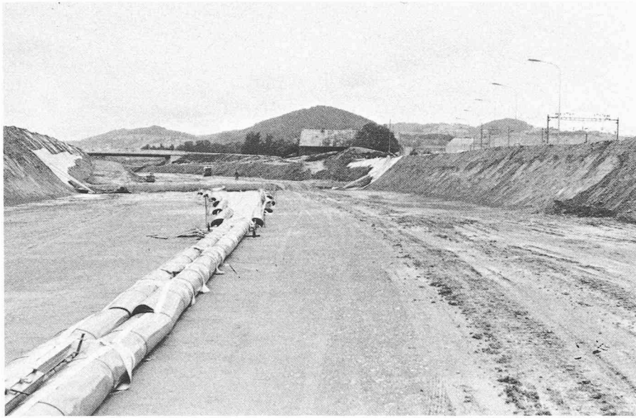
Fig. 7. — Des feuilles d'étanchéité synthétiques déjà posées sur la fondation aplaniée. (Photo prise par l'auteur)
