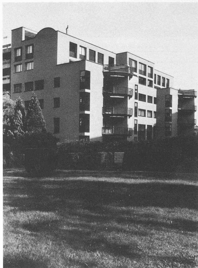
Fig. 12. — Immeuble Gartenstrasse, vu de l'ouest (ci-dessus).
