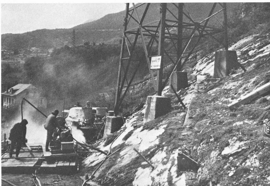
Fig. 12. — Ancrages VSL, dans la zone du pylône à haute tension.
