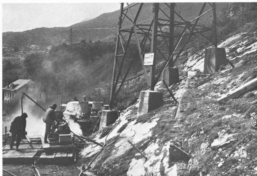
Fig. 12. — Ancrages VSL, dans la zone du pylône à haute tension.
