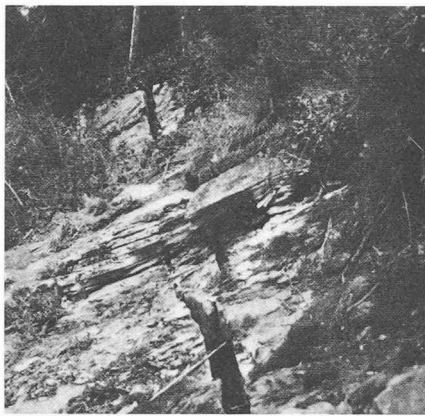
Fig. 3. — Grande fissure, à l'amont.
