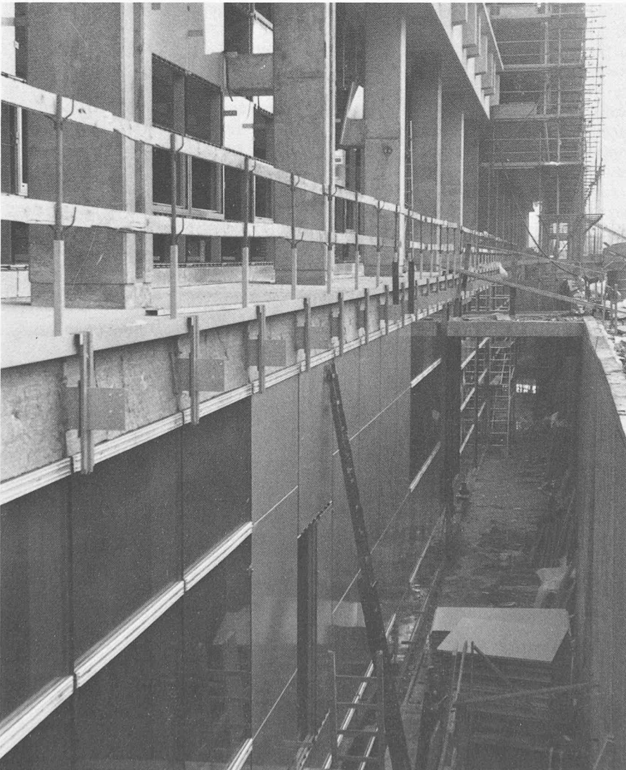
Fig. 8 — Vue en enfilade de la façade est du bâtiment d'exploitation. Détail du puits de lumière servant à l'éclairage naturel de l'étage inférieur.
