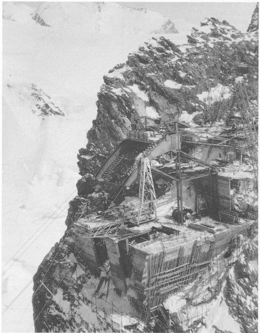
Fig. 5. — Station supérieure pendant la construction.
