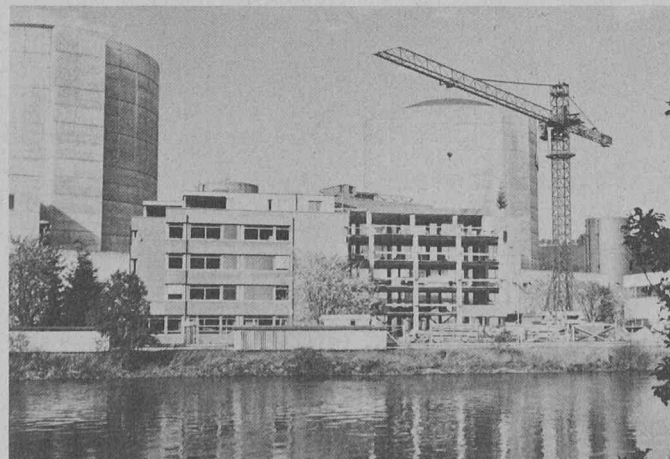
Bâtiment d'accès de la centrale nucléaire de Beznau I et II. A gauche le bâtiment administratif, à droite gros œuvre du bâtiment d'accès.
