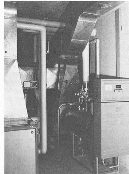
Fig. 26. — Centrale sous-sol: humidification — vapeur.
