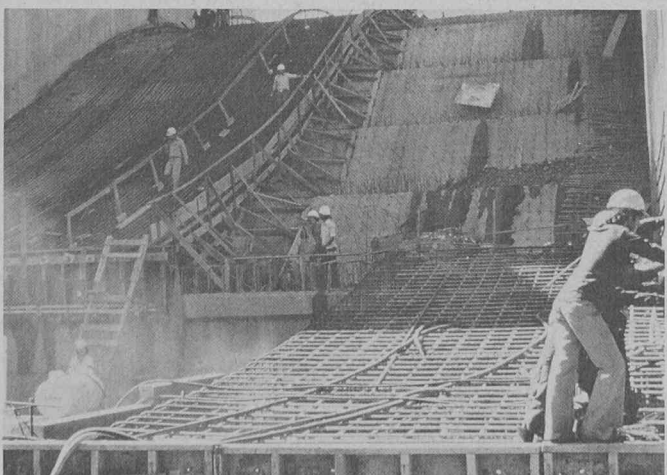
Sur le plus grand chantier du monde, à Itaipu, les ingénieurs se fient entièrement au niveau Wild N2, muni d'une nivelle à double face unique en son genre, conçue par l'inventeur suisse.
