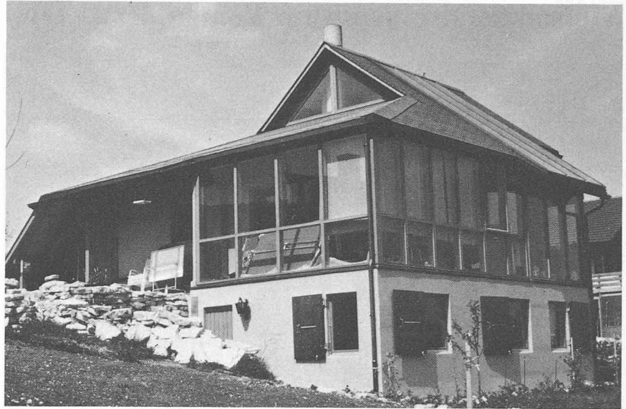
Fig. 2 — Façades sud et ouest.
