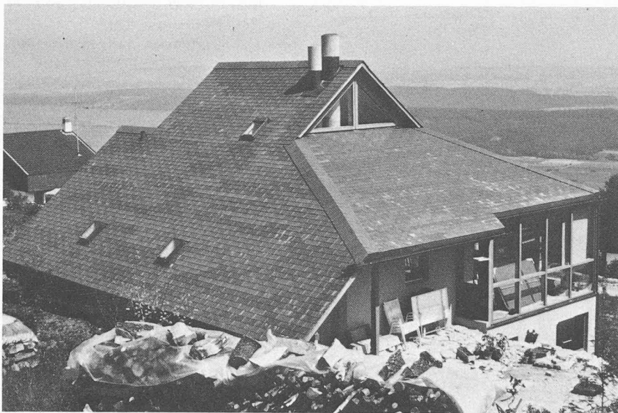
Fig. 3 — Façades ouest et nord.
