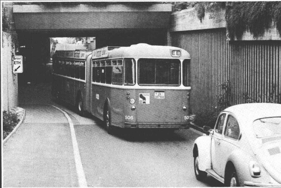
EPF Zürich, Leonardstrasse, Trafic lourd de la Leonardstrasse reposant sur la Mensa.
