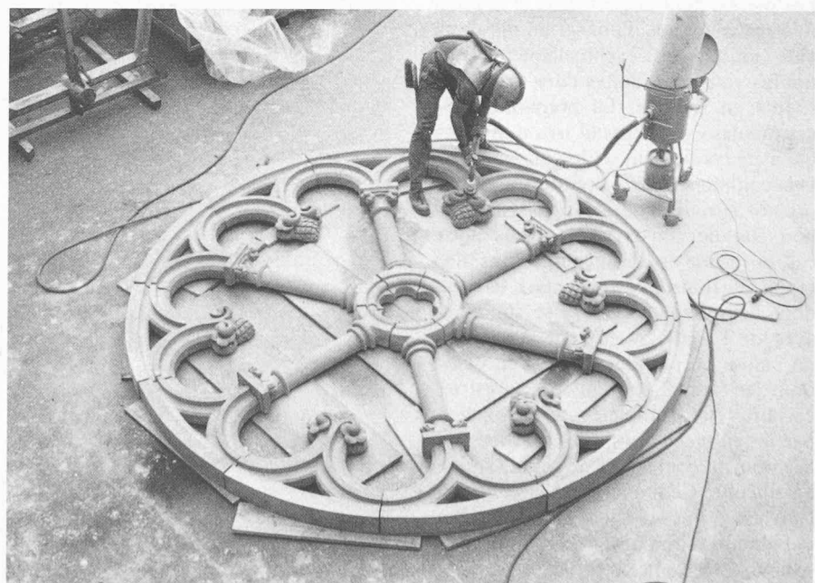
Fig. 7. — Sablage de la rose assemblée au sol.
