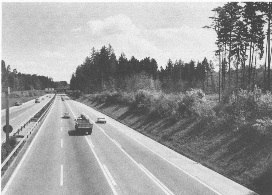
Si l'on ouvre une tranchée dans un peuplement fermé, le risque de renversement par le vent est élevé. Avec le temps, les dégâts progressent constamment dans les forêts adjacentes.
