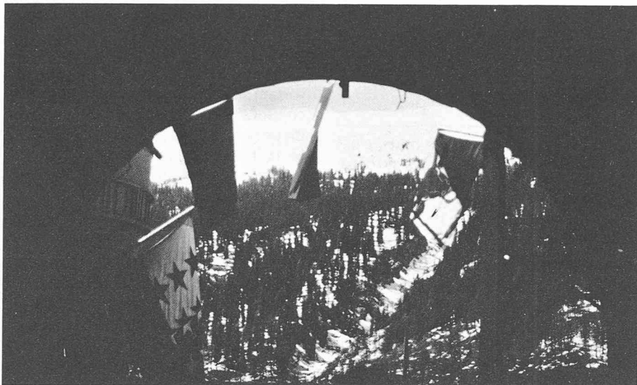
Fig. 2. — La fin du tunnel.
