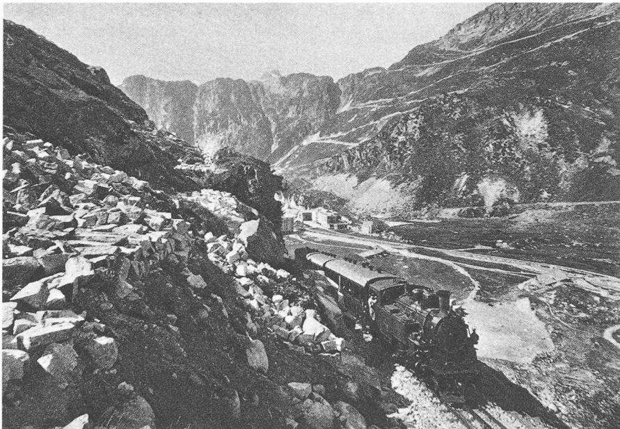
Fig. 1. — Pittoresque, mais peu rentable! Un train quitte Gletsch à destination de Realp, dans les années trente. (Photo Schnegg)
