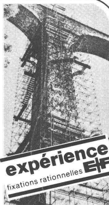
Fixation d'un coffrage
