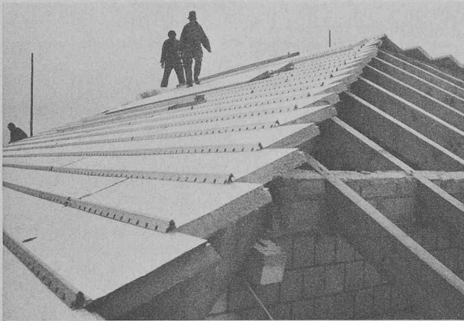
Travail de pose simplifié: la toiture isolante Polytec.
