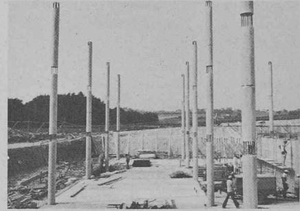
Colonnes avec tête de poinçonnement en acier.
