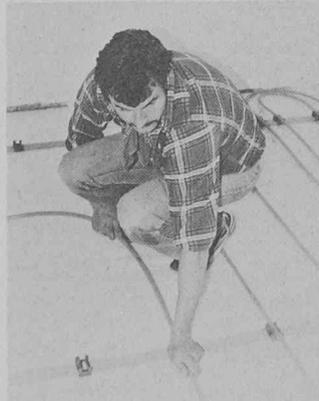
Montage précis et sûr du chauffage par le sol *Unitex* par la méthode d'étréage rapide.
