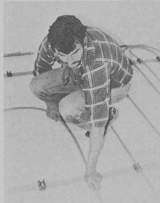
Montage précis et sûr du chauffage par le sol Unitex par la méthode d'étrépage rapide.
