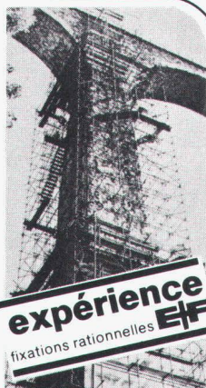
Fixation d'un coffrage
