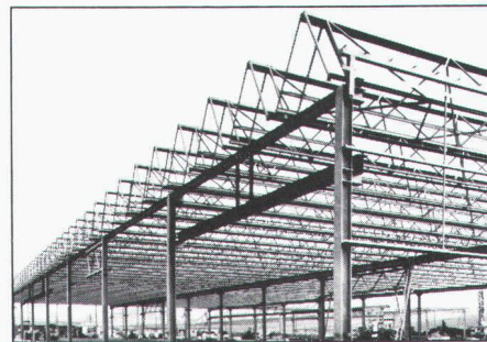
Structure métallique d'une usine – toiture mini-shed –
