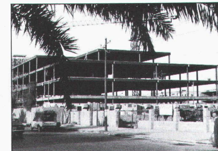
Structure métallique d'un bâtiment à étages destiné à l'enseignement en Arabie Saoudite
