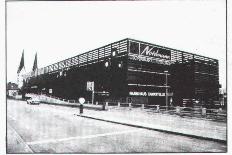
Parking à étages avec accès par rampes
